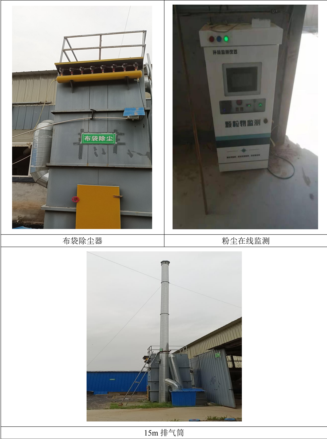
图 4-1 环保设施现场照片
